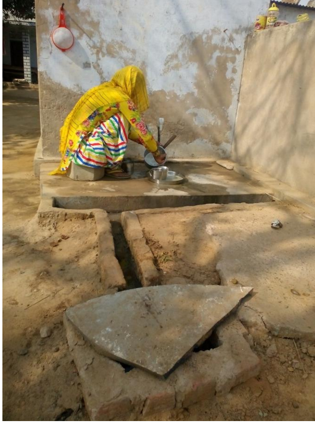
(भैडा की ढाणी में बर्तन धोने के लिए टंकी के पास बनी चबूतरी व नाली से सोखती कुई में जाता पानी)
