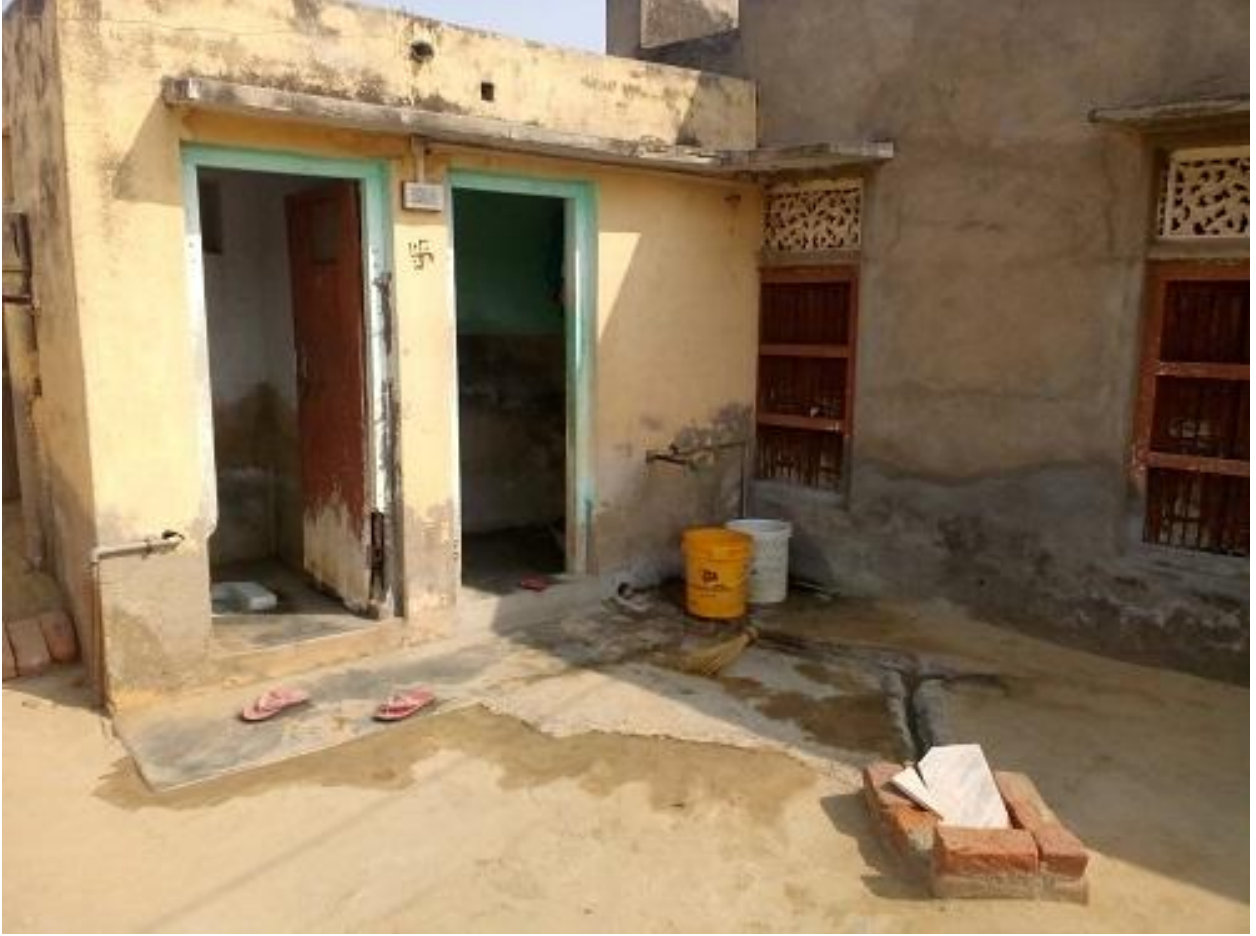
(भेडा की ढाणी में नहाने के पानी का निस्तारण के लिए बाथरूम के पास बनी सोखती कुई)
